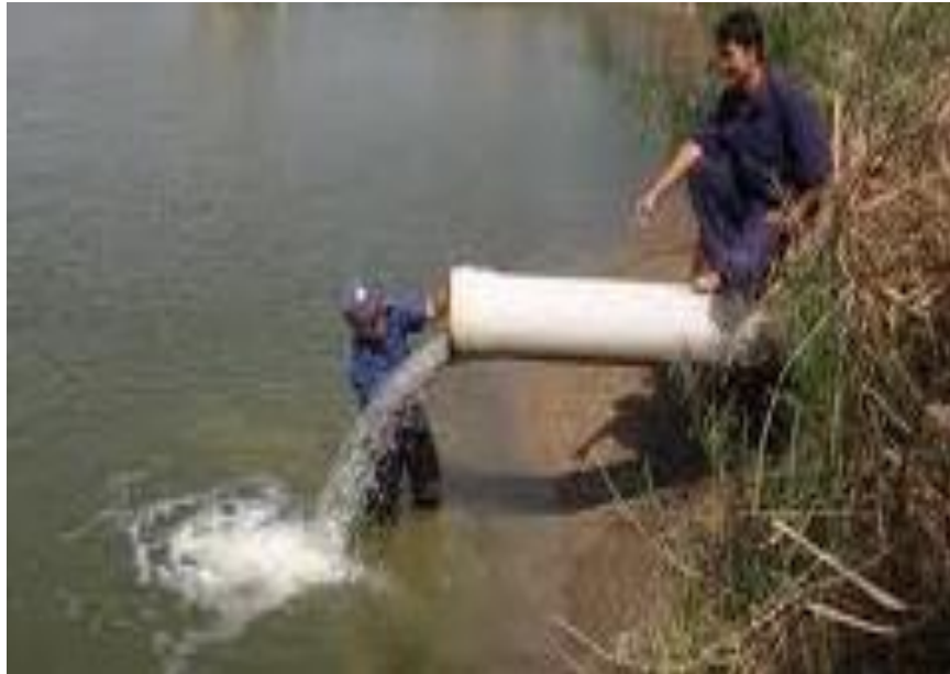
Hình 23.02.04: Cấp nước qua cống
