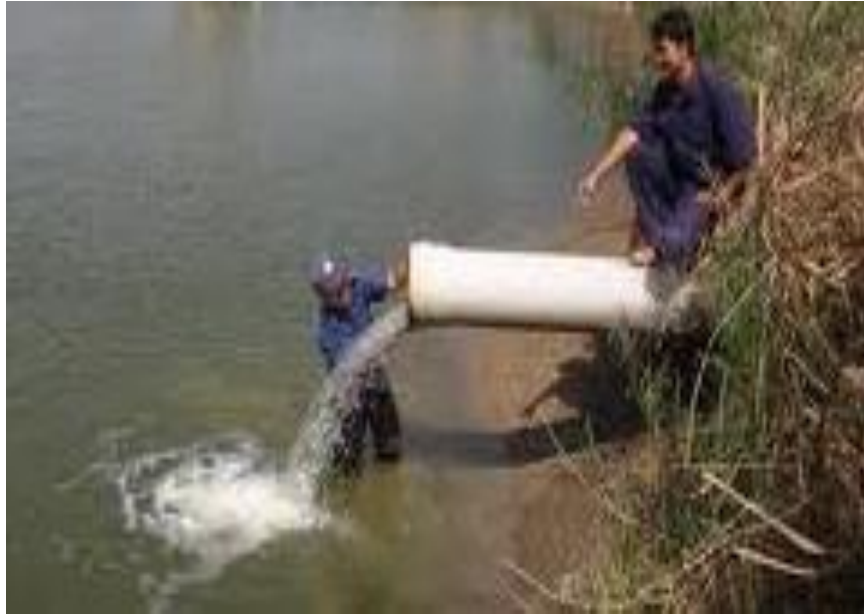
Hình 23.03.02: Cấp nước qua cống
