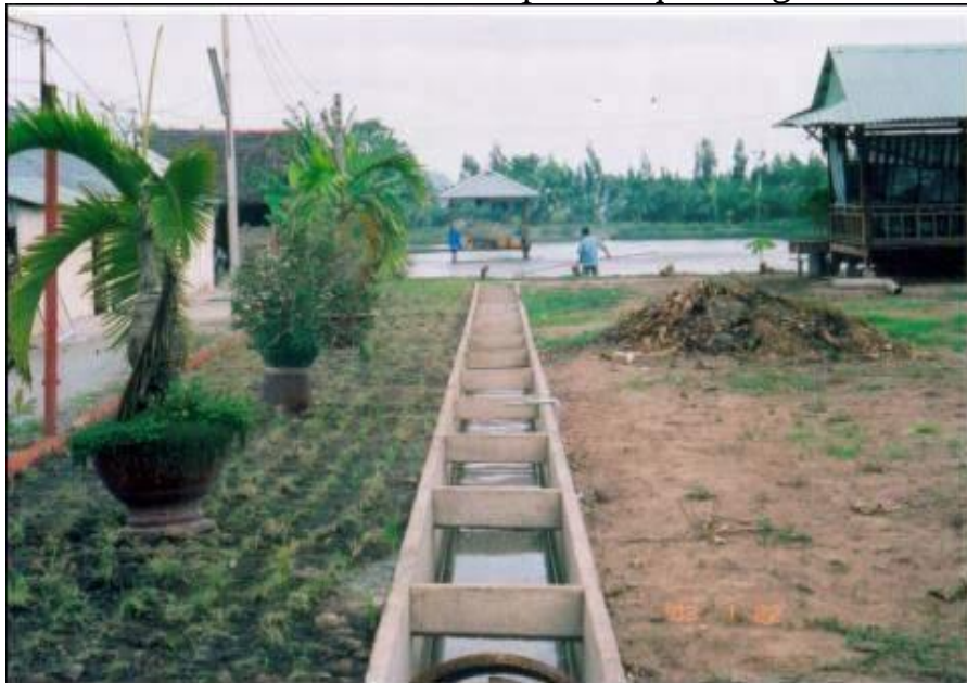
Hình 1.16: Cấp nước qua hệ thống mương cấp
